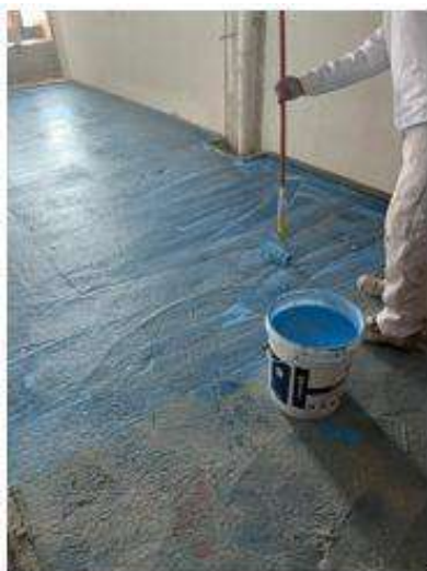
Imprimación de la superficie
